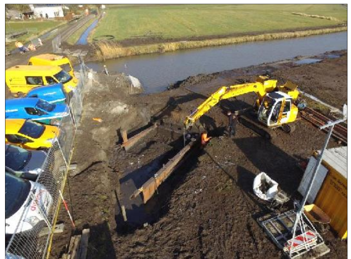
Het aanleggen van de maaibootinlaatplaats
