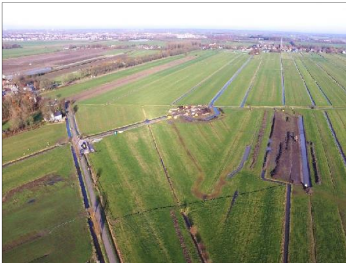
November 2016, tijdens de werkzaamheden aan de stuw en vispassage
