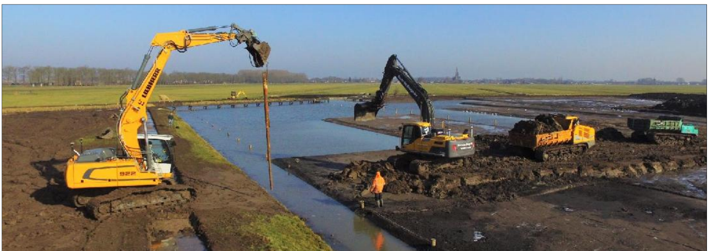
Het plaatsen van inundatiepalen en het ontgraven van het inundatieveld
