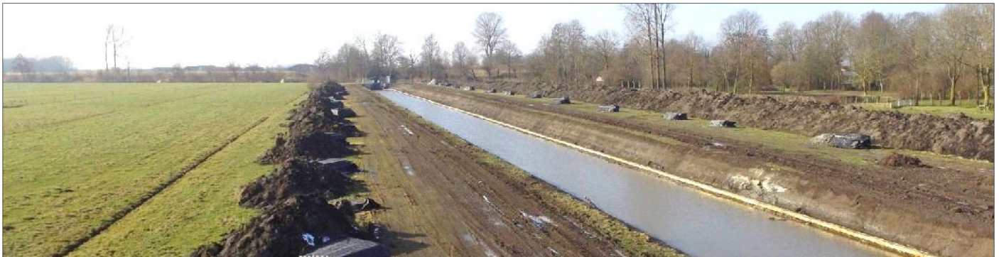
De Blokhovense wetering. Langs de wetering ligt vrijgekomen grond tijdelijk opgeslagen en liggen de blokkenmatten klaar om verwerkt te worden
