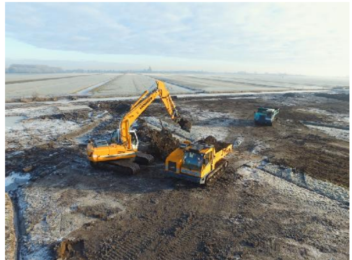
Voor het transport binnen het werkgebied wordt gebruik gemaakt van rupsdumpers.
