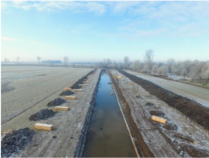
De Blokhovense wetering waarvan de rechterzijde al voorzien is van damwand.
