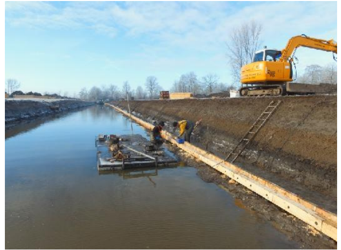
Het aanbrengen van een gording en grondankers aan de damwand.
