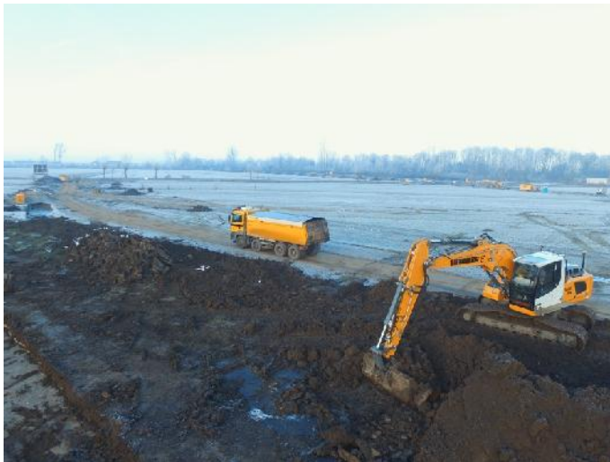
Het ontgraven van klei en het transport via een rijplatenbaan met vrachtauto's.
